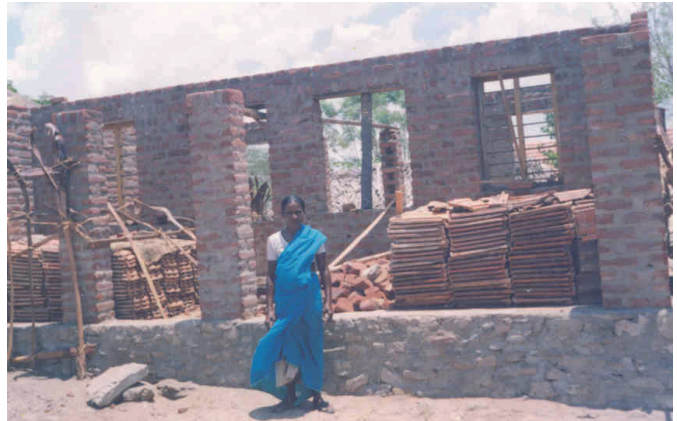
Haus im Rohbau
